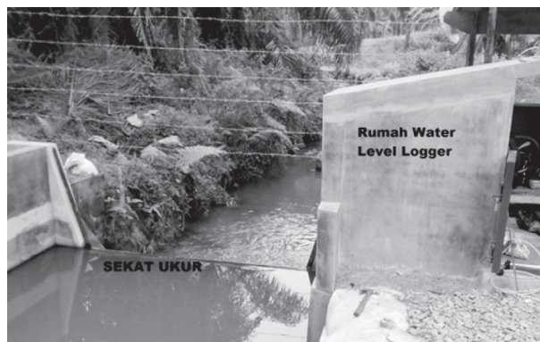
Gambar 1. Sekat Ukur dan rumah Water Level Logger pada lokasi penelitian.
