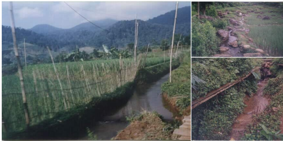
Gambar 3. Saluran irigasi sederhana atau irigasi dengan bangunan saluran semi permanen
