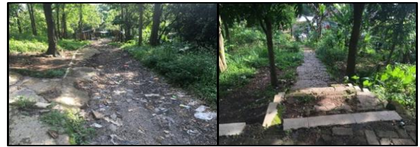
Gambar 10. Jalan Setapak Taman
