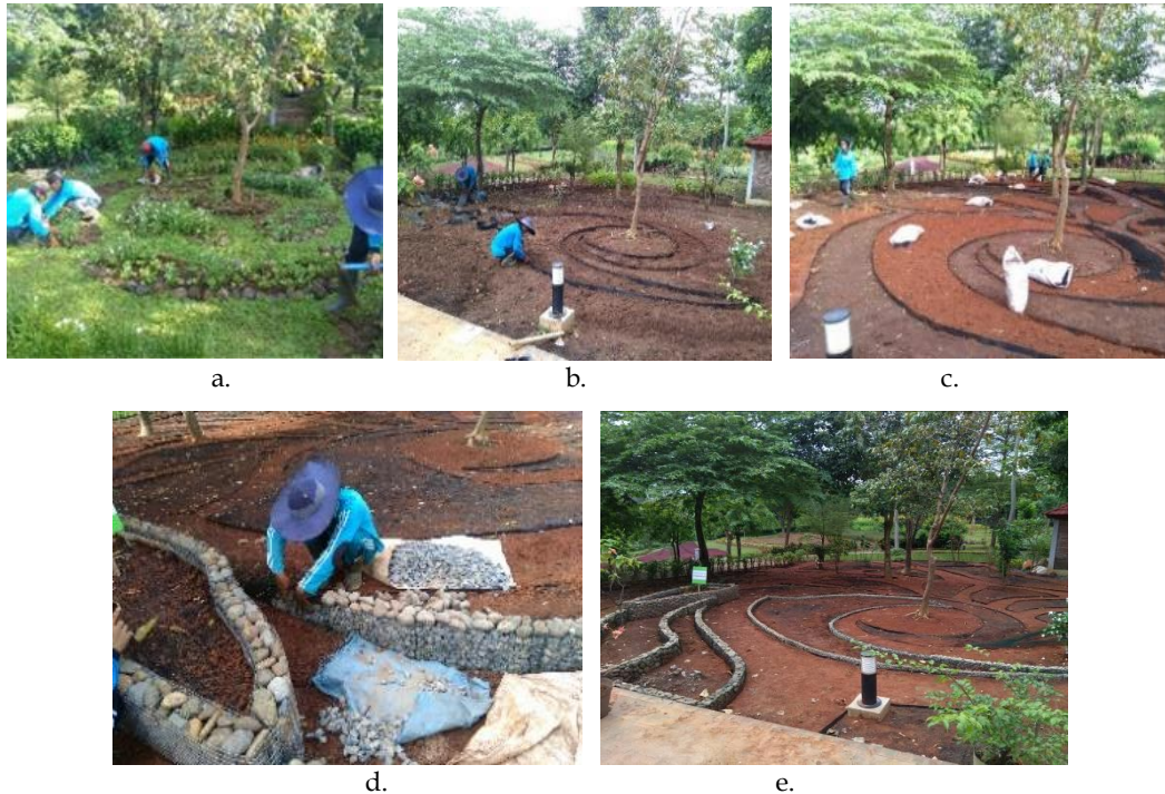
Gambar 7. a) Pembongkaran, b) Pembuatan Pola Taman dengan Geomembran, c) Penambahan Tanah Merah dan Kompos, d) Pembuatan Batas Ruang dengan Gabion, e) Pola Taman
