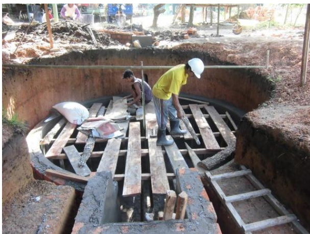
.Gambar 1 Pembuatan reaktor
